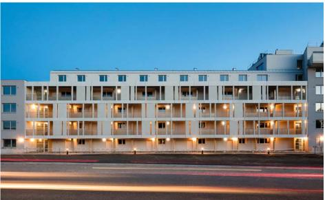
monolithisch gegossene Fertigbetonelemente aus Weißzement mit sandgestrahlter Oberfläche gewählt – ein Material, jedoch mit unterschiedlicher, prägnanter Wirkung: "Der markante, kräftige Rhythmus der Balkonvolumina sollte bewusst im auffallenden Kontrast zur tanzenden Partitur der flachen Betonelemente des Laubengangs stehen", erläutert Mark Gilbert.
