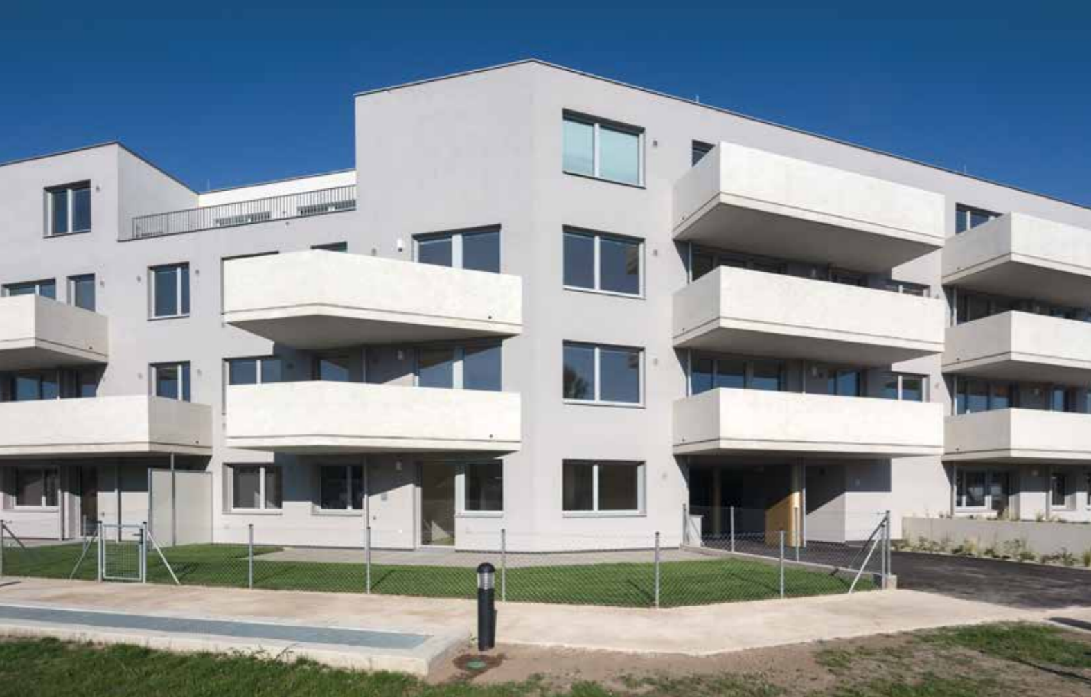
Il rivestimento dei prospetti in stucco grigio chiaro e i profondi balconi aggettanti in stucco bianco
