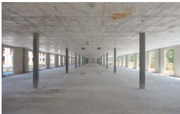
Rohbau des mit dem SLIM BUILDING® System errichteten HOME 21
