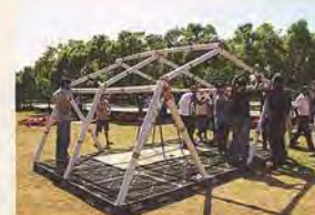
Der japanische Architekt Shigeru Ban entwarf speziell für Nepal eine feuchtigkeitsresistente Architektur aus Papprohren und Holzrahmen, die an Ort und Stelle ausgemauert werden
