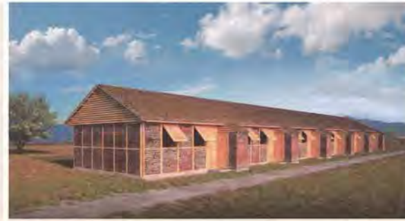
Der japanische Architekt Shigeru Ban entwarf speziell für Nepal eine feuchtigkeitsresistente Architektur aus Papprohren und Holzrahmen, die an Ort und Stelle ausgemauert werden
