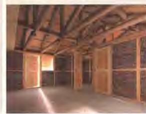
Der japanische Architekt Shigeru Ban entwarf speziell für Nepal eine feuchtigkeitsresistente Architektur aus Papprohren und Holzrahmen, die an Ort und Stelle ausgemauert werden
